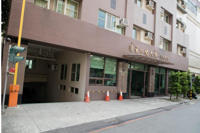
大樓外觀 Buildings
